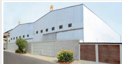
PLANTA 6 Transformadores de Potencia Jr. Luis Carranza 1905 - Lima 1
