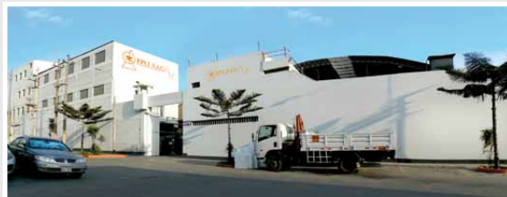
PLANTA 5 Metal Mecánica - Tableros y Celdas Jr. Luis Carranza 2089 - Lima 1
