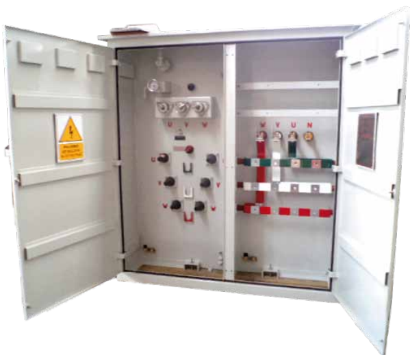
TRANSFORMADOR COMPACTO PEDESTAL
